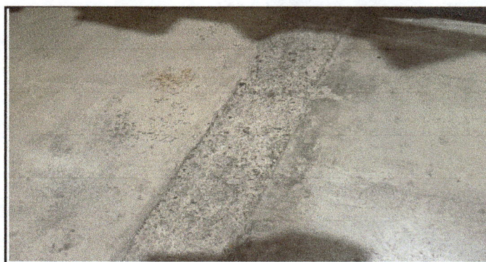
Foto 6: Modulo 1. Sustitucion de piso entortado por piso ceramico
