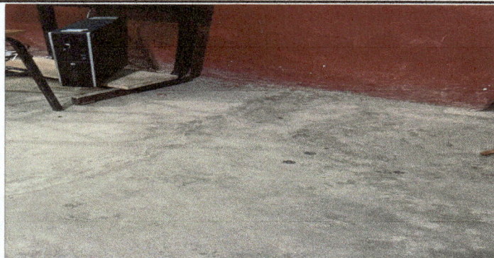
Foto 7: modulo 2. cambio de piso de torta por piso cerámico aula 6
