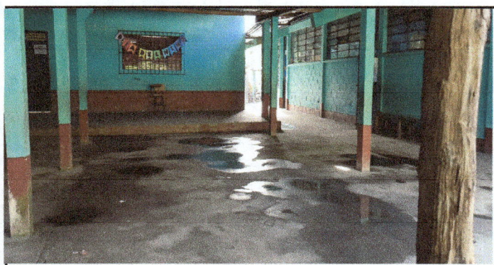
Foto 5: Modulo 2 (corredor) cambio de columna de madera a metal para soporte de estructura del techo.
