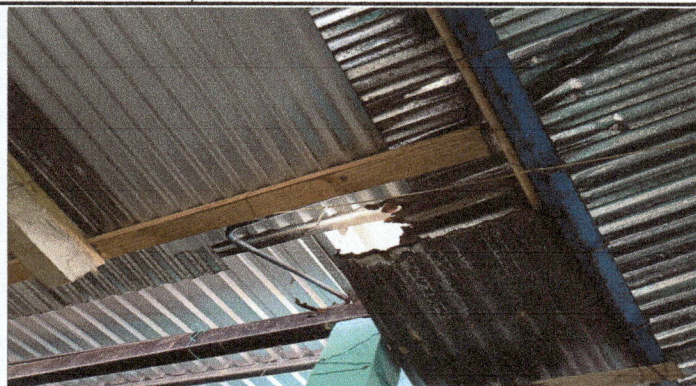
Foto1: Modulo 1. Sustitucion de lámina por lamina troquelada maxalum calibre 26 original
