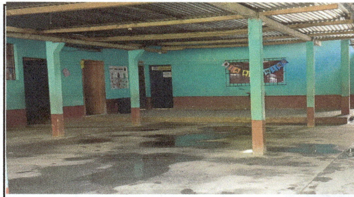
Foto 4: Modulo 2 (corredor) Sustitucion de lámina por lamina troquelada maxalum calibre 26 original
